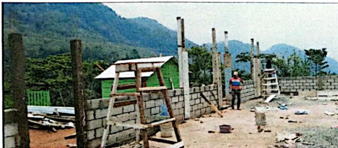
Foto 3: Etapa de fundición de las columnas.
